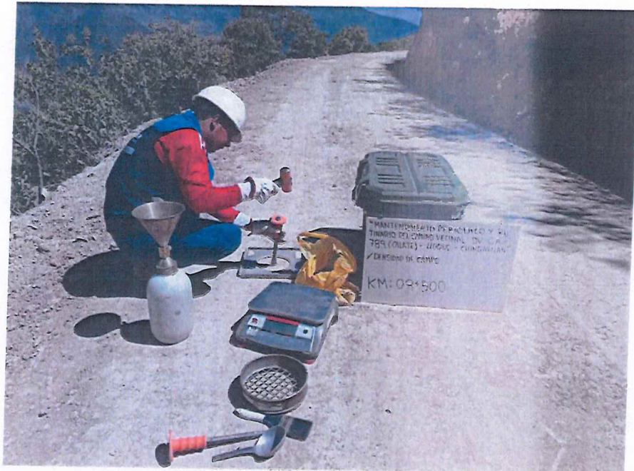
FIGURA N° 39. Ensayo de Densidad de Suelo en Campo. Progresiva 09 + 500 (Método del cono de arena).
