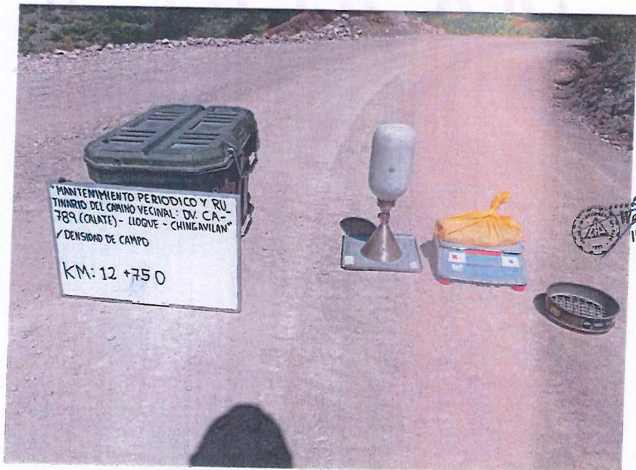
FIGURA N° 52. Ensayo de Densidad de Suelo en Campo. Progresiva 12 + 750 (Método del cono de arena).
