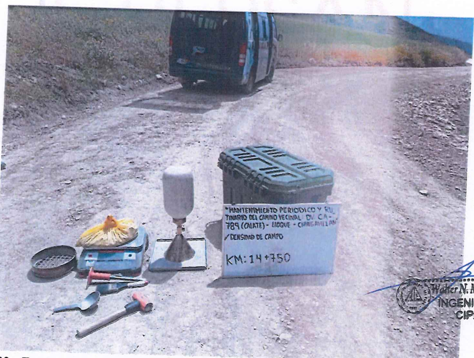
FIGURA N° 60. Ensayo de Densidad de Suelo en Campo. Progresiva 14 + 750 (Método del cono de arena)
