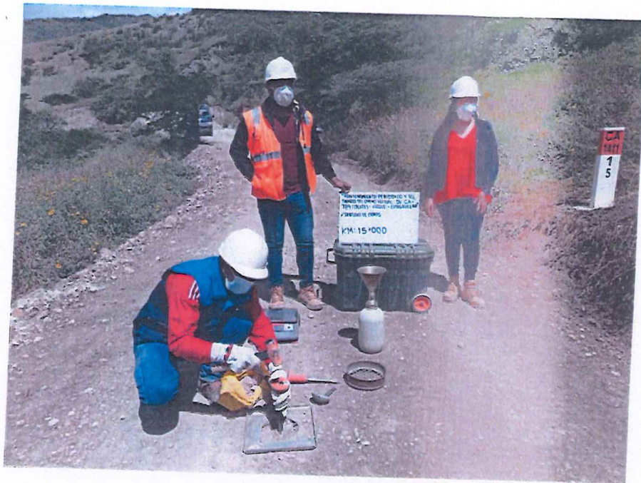
FIGURA N° 61. Ensayo de Densidad de Suelo en Campo. Progresiva 15 + 000 (Método del cono de arena).
