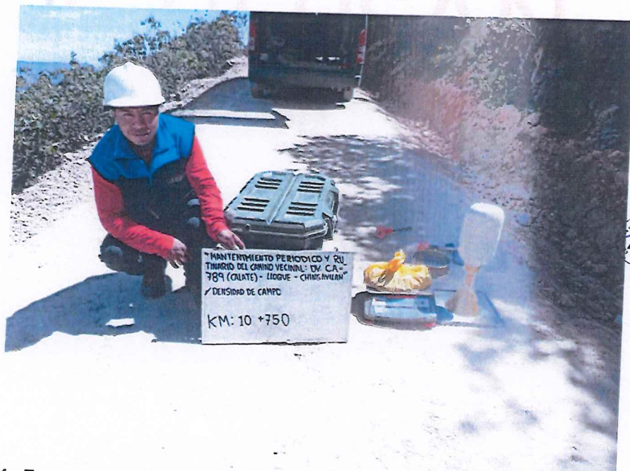
FIGURA N° 44. Ensayo de Densidad de Suelo en Campo. Progresiva 10 + 750 (Método del cono de arena).
