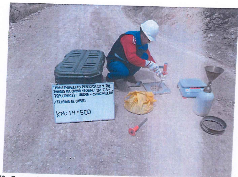
FIGURA N° 59. Ensayo de Densidad de Suelo en Campo. Progresiva 14 + 500 (Método del cono de arena).
