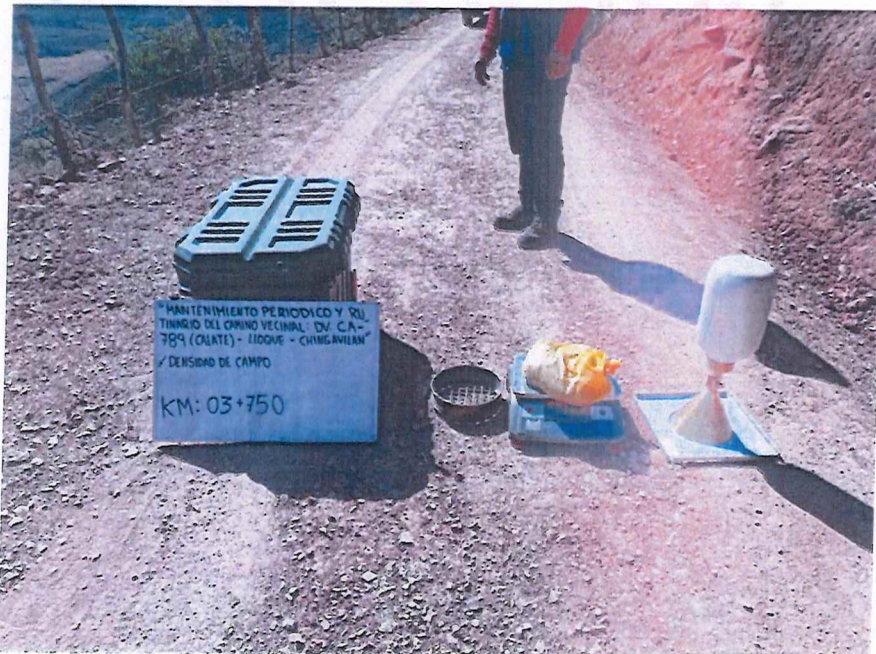
FIGURA N° 16. Ensayo de Densidad de Suelo en Campo. Progresiva 03 + 750 (Método del cono de arena).
