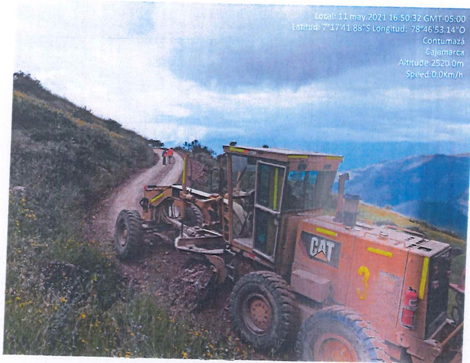
Ilustración 7. Conformación de la capa de afirmado.
