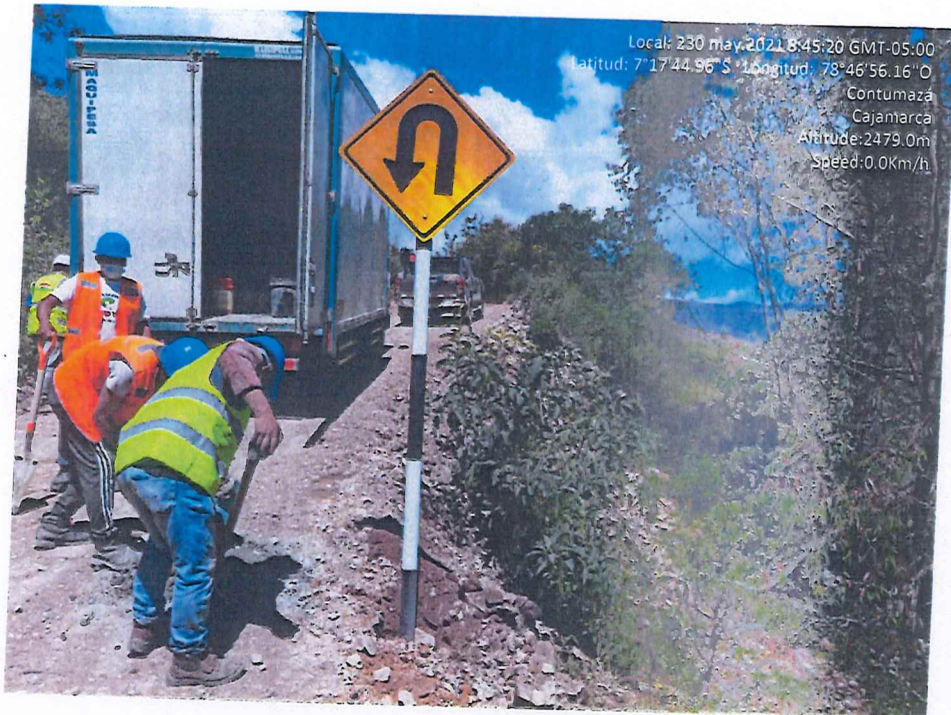
Ilustración 17. Colocación de la señal preventiva.
