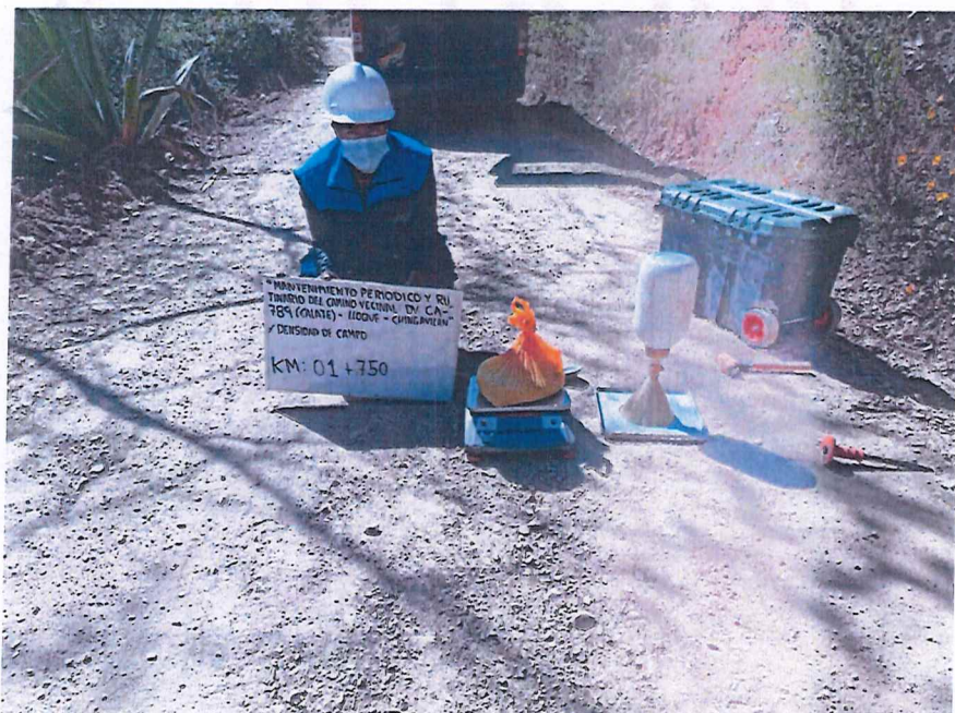
FIGURA N° 8. Ensayo de Densidad de Suelo en Campo. Progresiva 01 + 750 (Método del cono de arena).
