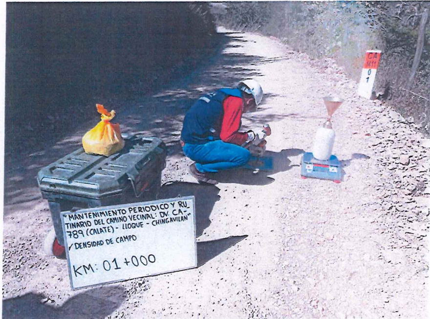
FIGURA N° 5. Ensayo de Densidad de Suelo en Campo. Progresiva 01 + 000 (Método del cono de arena).
