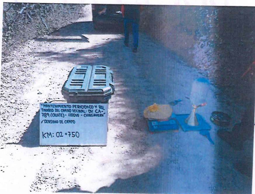
FIGURA N° 12. Ensayo de Densidad de Suelo en Campo. Progresiva 02 + 750 (Método del cono de arena).
