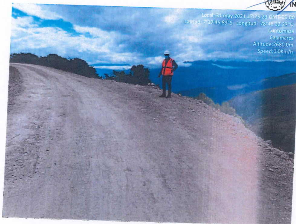
Ilustración 10. Resultado de la compactación del material de afirmado.
