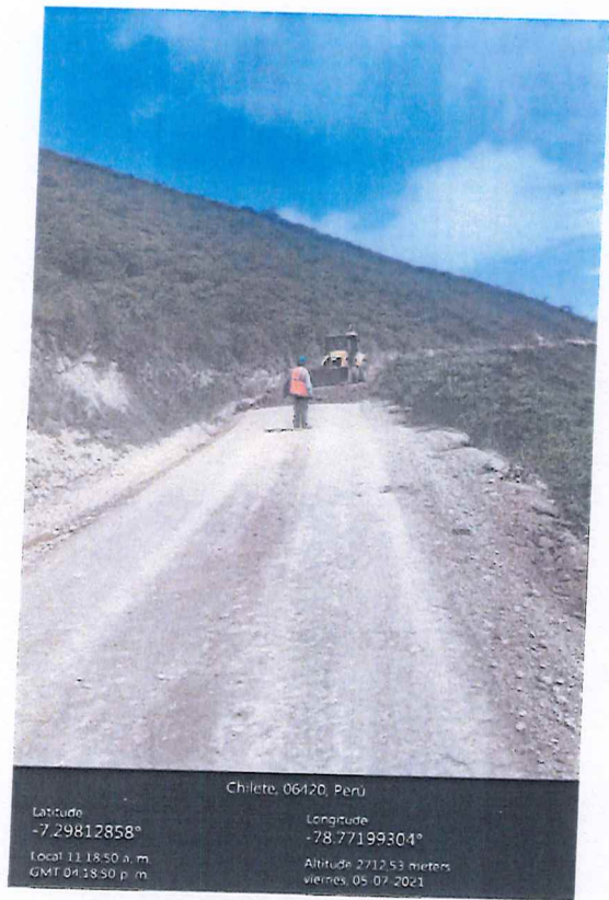
Ilustración 6. Extendido de material.
