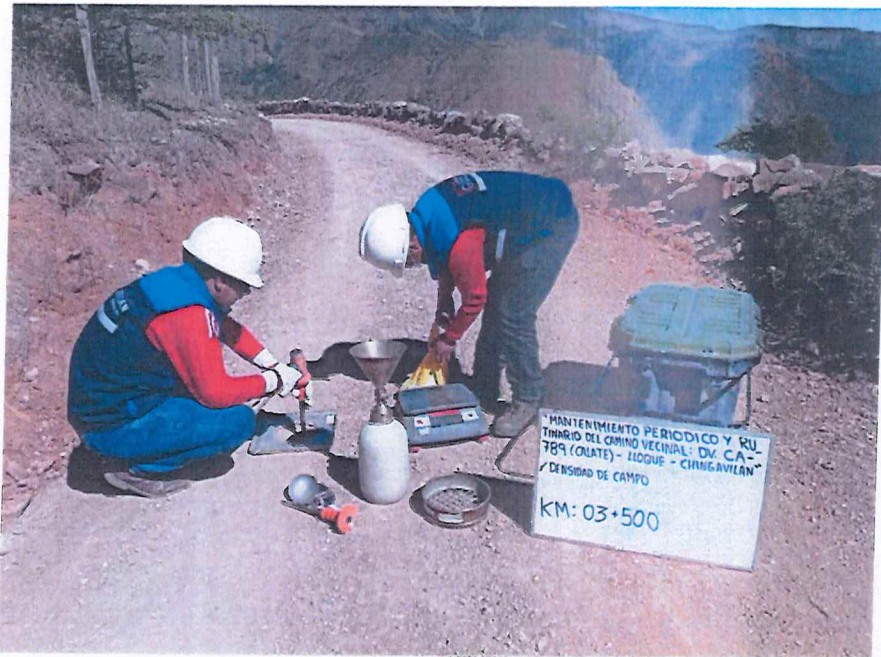
FIGURA N° 15. Ensayo de Densidad de Suelo en Campo. Progresiva 03 + 500 (Método del cono de arena).
