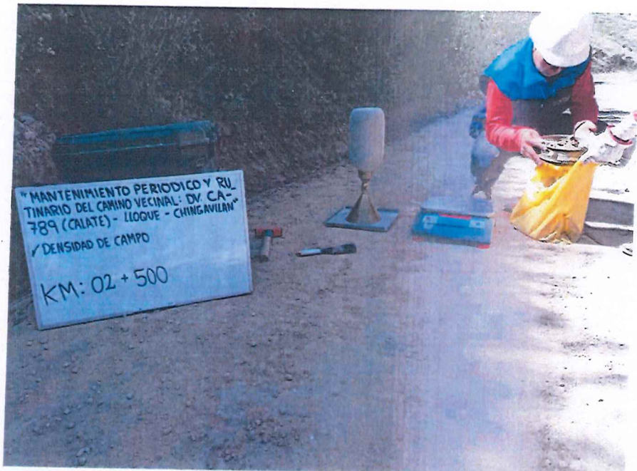
FIGURA N° 11. Ensayo de Densidad de Suelo en Campo. Progresiva 02 + 500 (Método del cono de arena).
