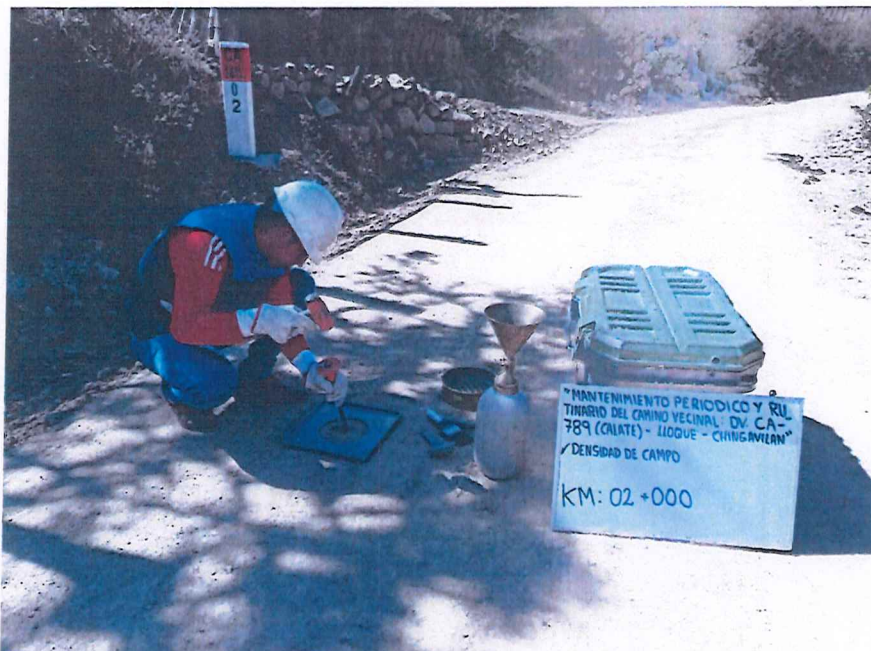
FIGURA N° 9. Ensayo de Densidad de Suelo en Campo. Progresiva 02 + 000 (Método del cono de arena).
