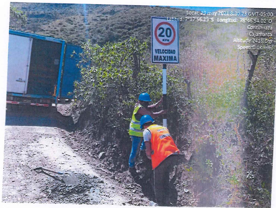
Ilustración 16. Colocación de la señal reglamentaria.
